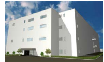
NEC神奈川データセンター
