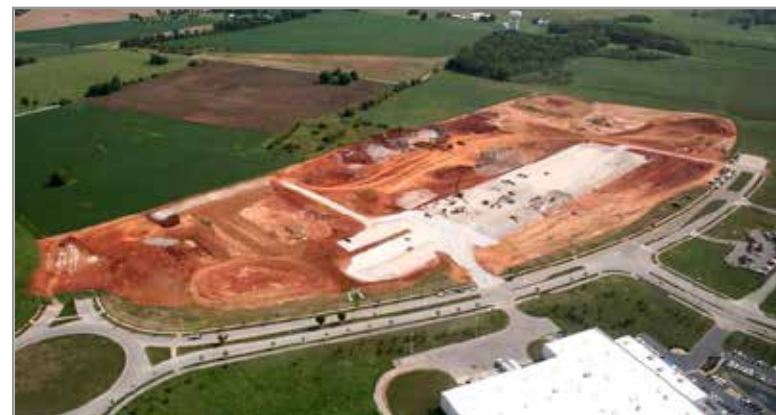
順調に整地が進んでいる工場建設用地
