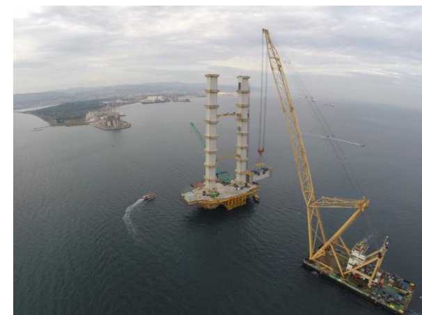
南側主塔の下水平梁の架設作業
