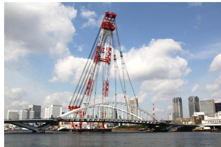
「築地大橋」の架設
