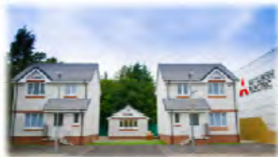
空調冷熱向け住宅型評価施設
