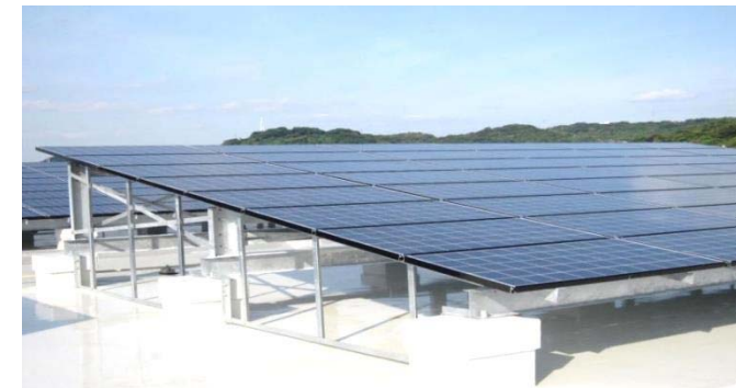
太陽光発電架台施工事例
