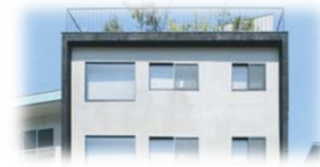
ビル・マンションリノベーション 商業ビル、賃貸・分譲マンション1棟丸ごと リノベーション
