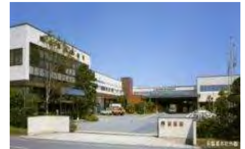
寿製菓(株) 本社工場
