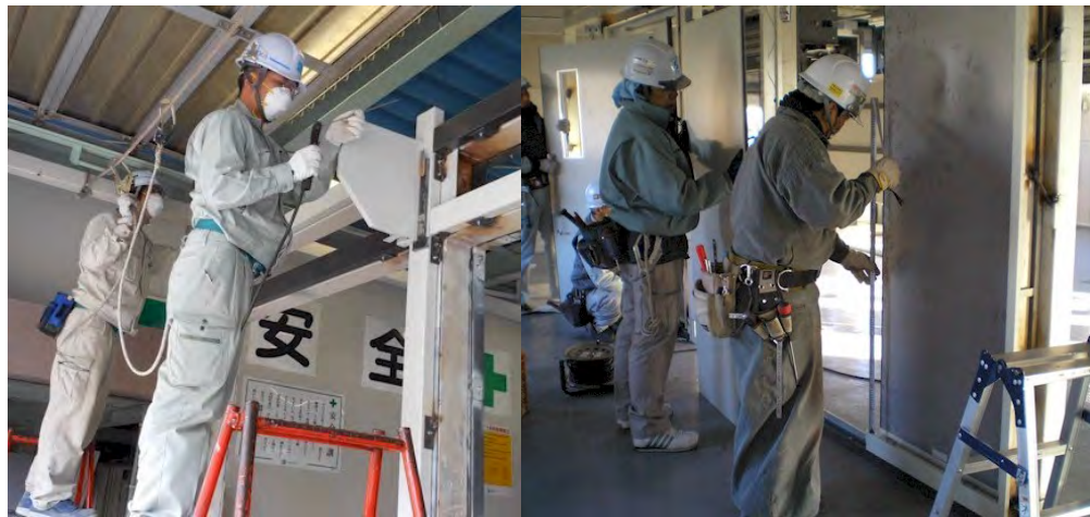
シャッター及びドアの施工研修の様子
