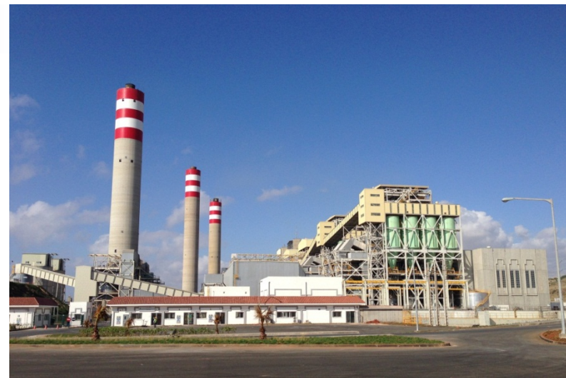
モロッコで稼働中のIHIが納めた大型石炭焚きボイラ
