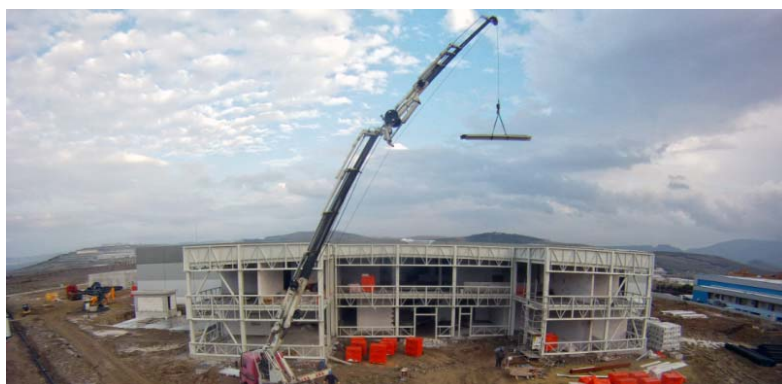
建設中の印刷インキ新工場(トルコ)
