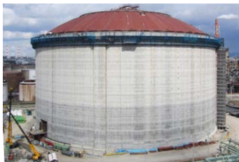
泉北製造所第一工場 5号タンクの完成
