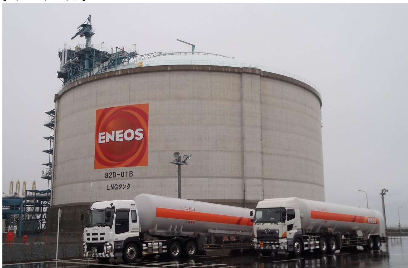
【八戸LNGターミナル】
