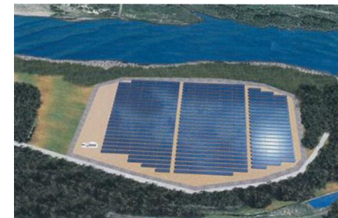
イメージ図（神奈中岩手県金ヶ崎太陽光発電所）
