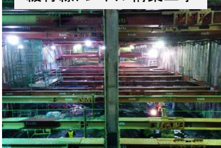
緩行線トンネル構築工事
