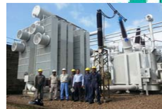
プラント施工
