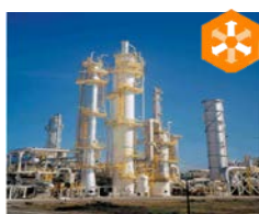
CO 2 回収装置
