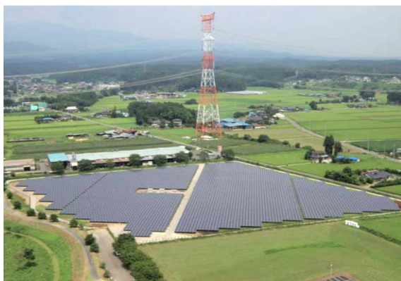
メガソーラー発電所
