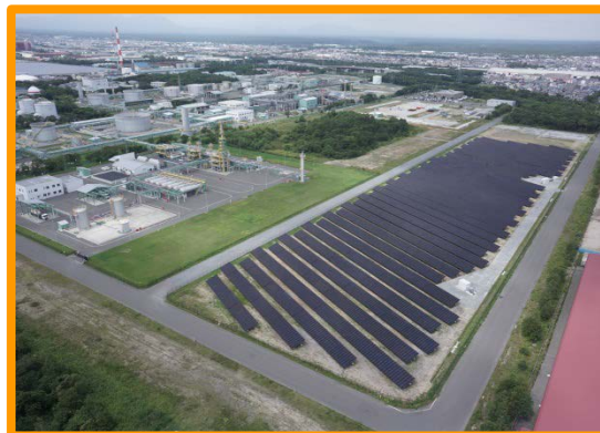
北海道鉱業所メガソーラー発電所
