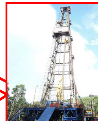
武佐岳地域での掘削作業
