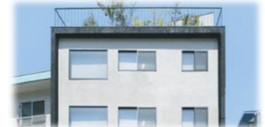
ビル・マンションリノベーション 商業ビル、賃貸・分譲マンション1棟丸ごと リノベーション
