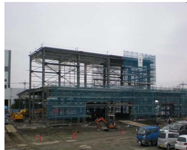
建設中の工場外観
