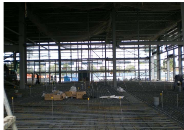
工事は順調に進行中
