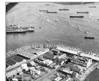
昭和30年代の北海製罐 函館工場と北洋漁業風景
