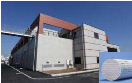
▲ 横浜市 川井浄水場 再整備事業
