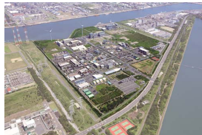
PPS樹脂の生産能力増設を進める鹿島工場 (茨城県)
