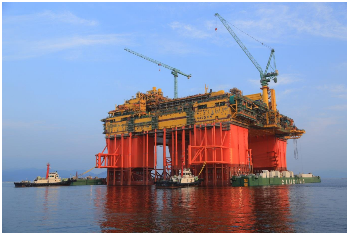
沖合生産・処理施設 (CPF) の進水
