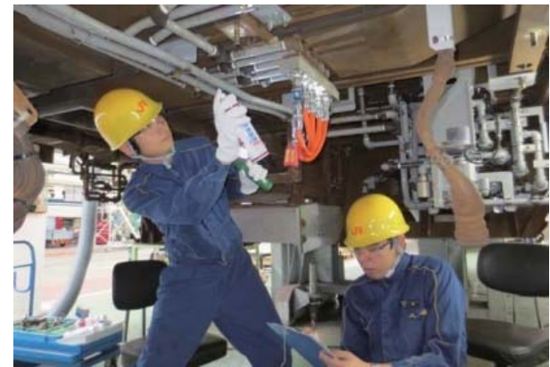
N700系改造工事
