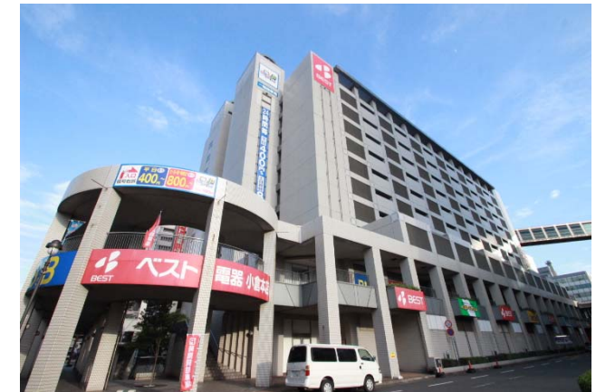
あるあるCity2号館(立体駐車場)
