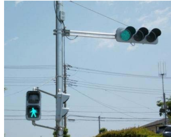
(施工例) 信号灯器取付金具
