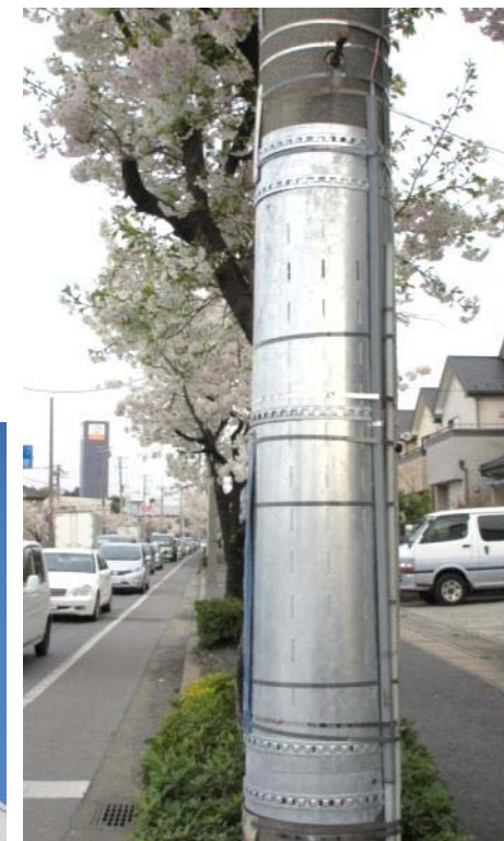
(施工例) 電柱補強板
