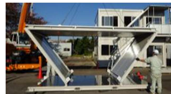
【屋根を吊り上げ柱が開いていく状態】
