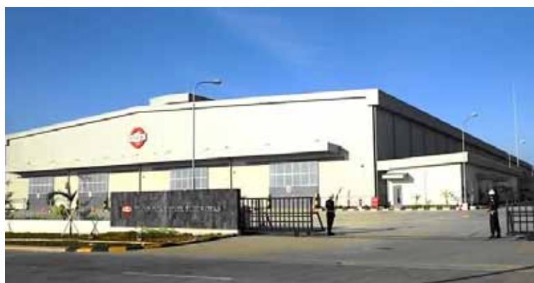
ジャカルタ東部 チカラン工場 (2013年8月完成)
