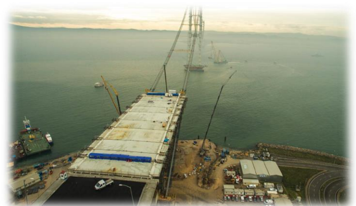
アプローチ部架設状況
