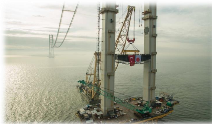
主桁架設状況(主塔部)
