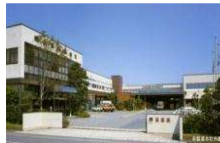
寿製菓(株) 本社工場
