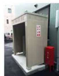
LPガス発電機(5kVA)とガスボンベ庫
