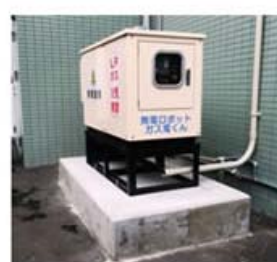
LPガス発電機(5kVA)とガスボンベ庫
