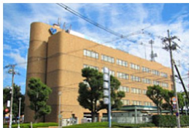
「スマートエネルギービル」としてCO2削減を進める北部ガスビル
