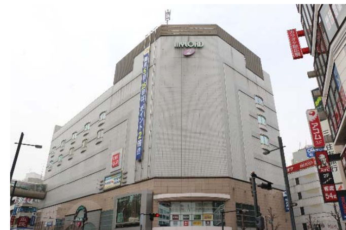
内装改修工事を実施した「本厚木駅前ビル」
