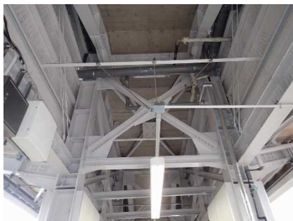
駅舎耐震補強
