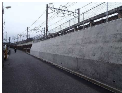
土留擁壁改良
