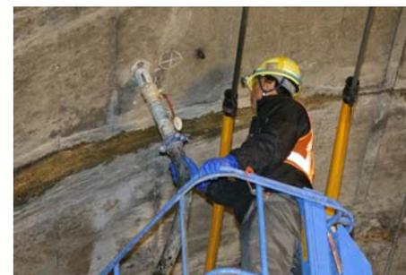
大規模改修工事(トンネル内覆工裏空隙充填)
