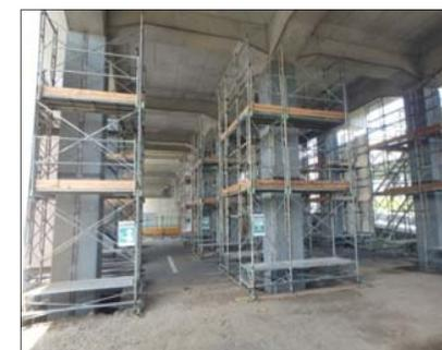
在来線高架橋柱耐震化(鋼板巻工法)
