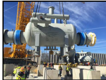
プロパンクーラー据付
