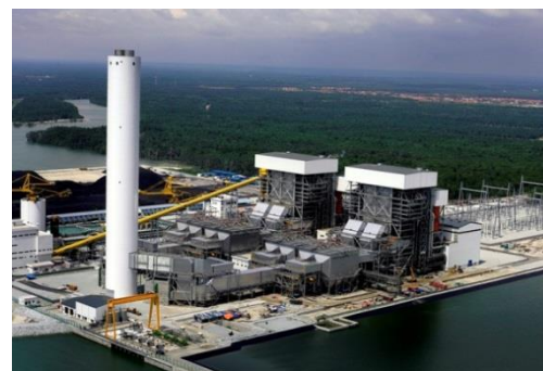
高効率大型石炭焚火力発電設備
