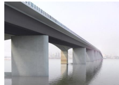
Bangladeshで建設中の メグナ第2橋 完成予想図 (手前が第2橋)
