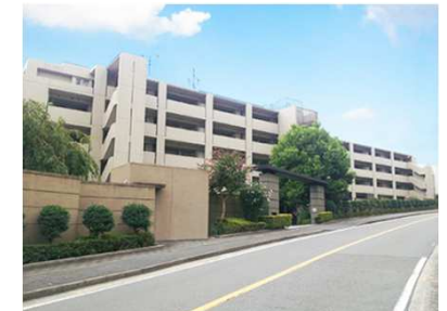
大規模修繕工事：フォルム横濱汐見台
