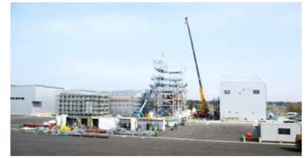
※花巻バイオマスエナジープラント設置工事(H28/4末時点)
