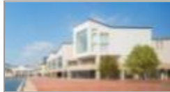
ハーバーテラスSASEBO迎賓館
