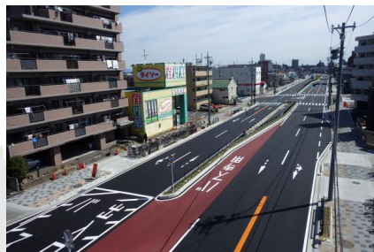
1号下之一色地区舗装工事
