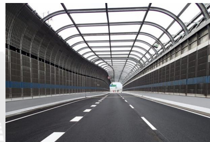
舗装補修工事（26-5-神）
