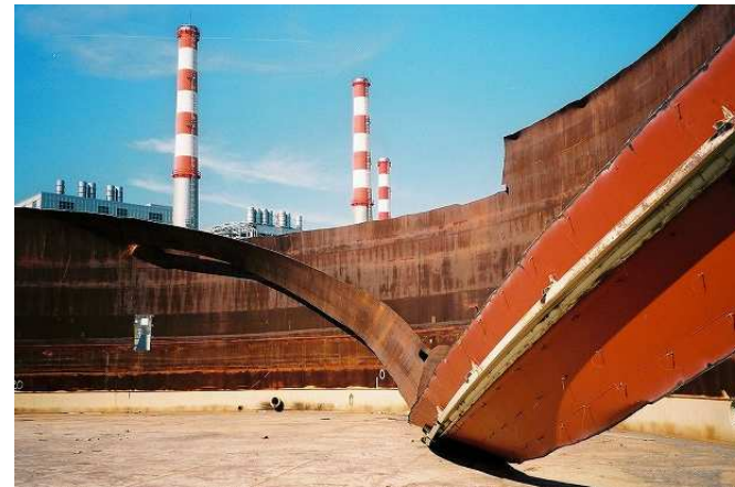
火力発電所（リンゴ皮むき工法）
