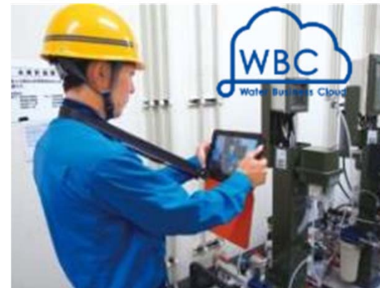
ICTを活用した維持管理
