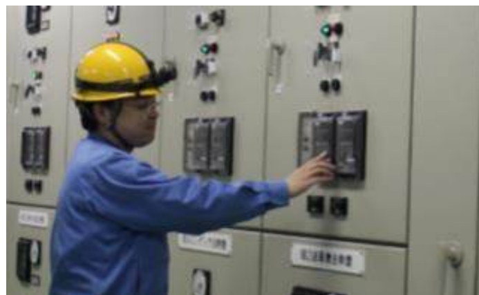
配電盤調整作業
