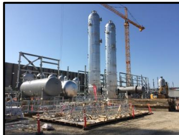
酸性ガス吸収塔据付
