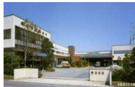
寿製菓(株) 本社工場
