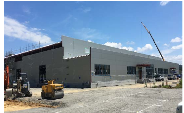
〔建設中の岡山新工場〕
