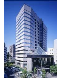
事B-6 川口センタービル
