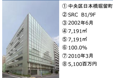
事A-20 JPR日本橋堀留ビル
