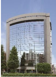
事A-15 南麻布ビル
