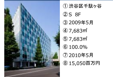
事A-21 JPR千駄ヶ谷ビル
