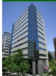
事B-8 立川ビジネスセンタービル
