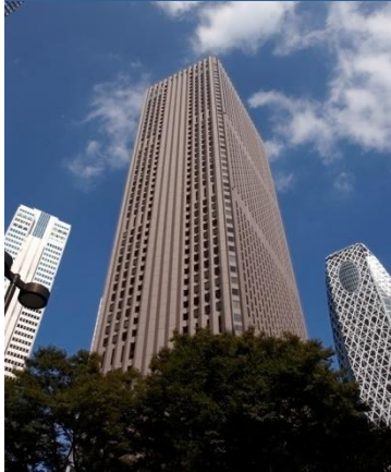
事A-14 新宿センタービル
