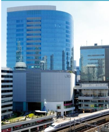
商A-5 有楽町駅前ビルディング(有楽町ビル)
