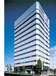
事B-5 新横浜第二センタービル
