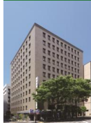
事B-3 JPR横浜日本大通ビル
