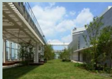
屋上庭園「スカイパーク」
