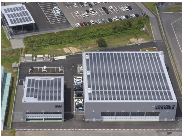
鹿児島格納庫 屋上太陽光パネル
