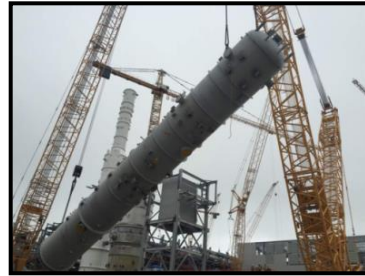
窒素除去塔据付
